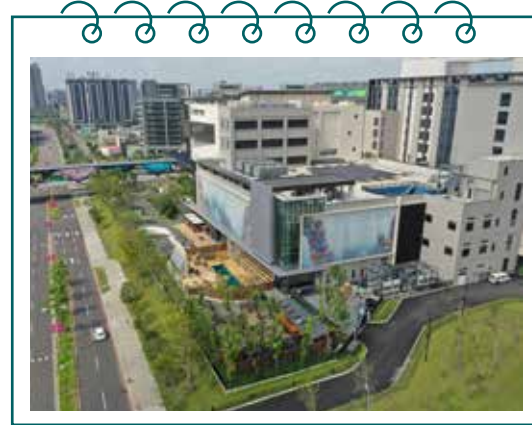
桃園 Xpark 為複合商業用大樓，2020 年取得銀級綠建築標章，設有高回收率的中水系統，飯店淋浴使用後的汙廢水會經由中水系統過濾後，做澆灌以及園區公共區域沖廁再利用。
